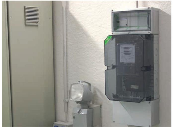
■ Корпуса для счетчиков ZKi для самостоятельной установки
