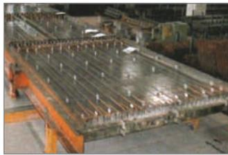
Монтаж коробок IBT осуществляется на опалубку перед заливкой бетона. После установки коробки соединяются трубами, а затем закрываются крышками.
