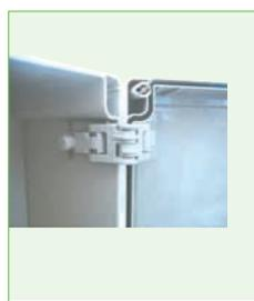
► Внутрирасположенные петли преобразуют съемную крышку в дверцу
